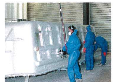
Pose des renforts + résine de protection
