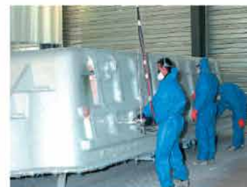
Pose des renforts + résine de protection
