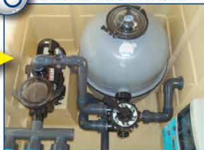
10 RÉALISATION DU LOCAL TECHNIQUE
