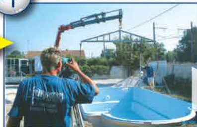
4 MISE À NIVEAU
